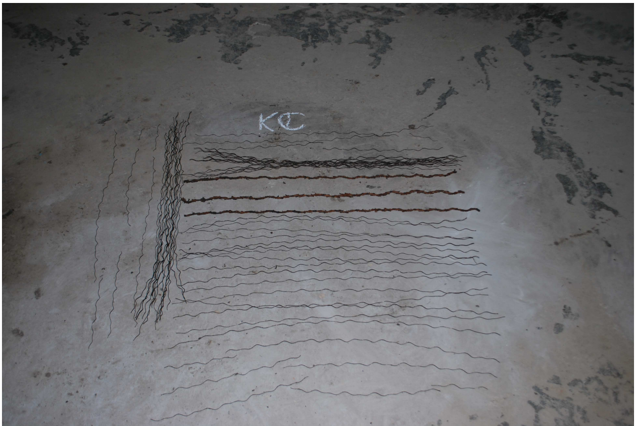
Фиг.5. Фотография оборванных проволок сердечника каната.
