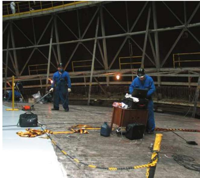
Рис. 3. Контроль технического состояния плавающей крыши резервуара хранения сжиженного газа (г. Виктория, Бразилия)
