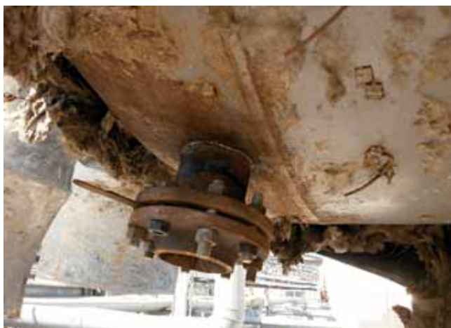
▲ Рис. 1. Место ремонта НГСВ № 2
