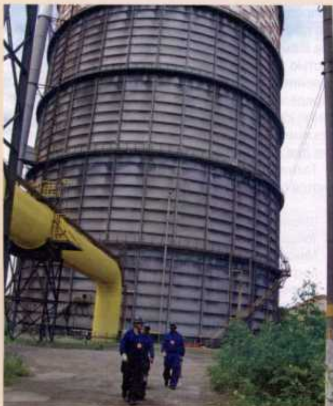
Рис. 2. Резервуар для хранения сжиженного газа на заводе Arcelor Mittal в г. Виктория (Бразилия)
