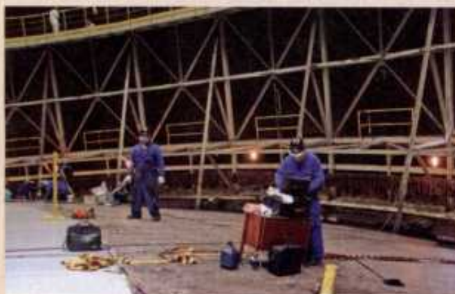
Рис. 3. Контроль технического состояния плавающей крыши
