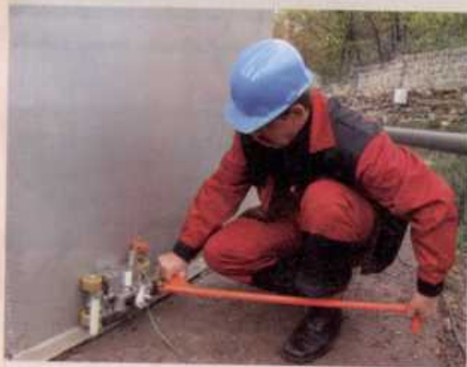
Рис. 1. Проверка дефектоскопом ИНТРОКОР М-150 на стальном листе зоны вблизи уторного шва
