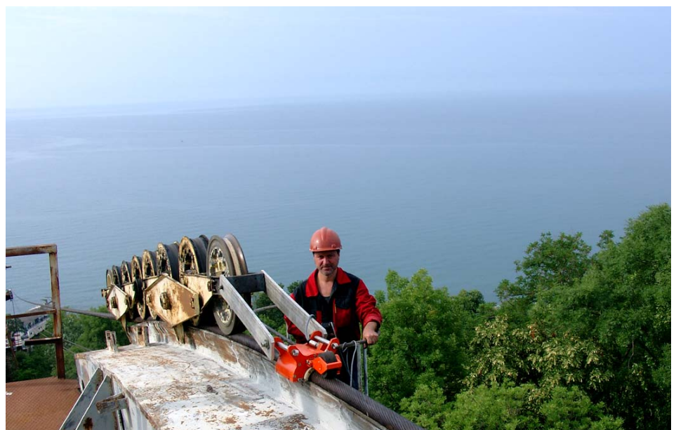
Рис. 4. Контроль несущего каната на башмаке опоры дефектоскопом ИНТРОС. ППКД «Заря», Сочи
