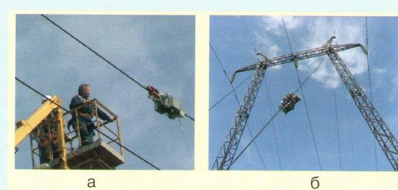
Рис. 3. Использование самоходного устройства при диагностике оборудования ВЛ
