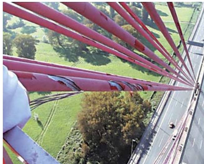
Рис. 6. Последствия нарушения замкового соединения Z-проволок наружного слоя закрытого каната
