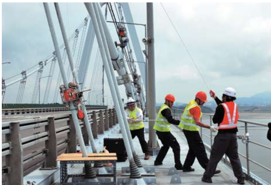
Рис. 2. Контроль вантовых канатов моста Йонджон дефектоскопом «ИНТРОС»
