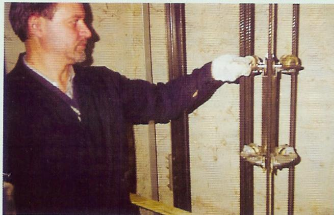
**Рис. 2. Установка раздвижного устройства на канаты лифта**
