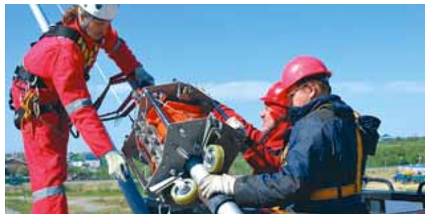
Фото 2. Дефектоскописты при помощи промышленного альпиниста устанавливают МГ 80-120 на ванту, изготовленную из каната закрытой конструкции (Салехард)
