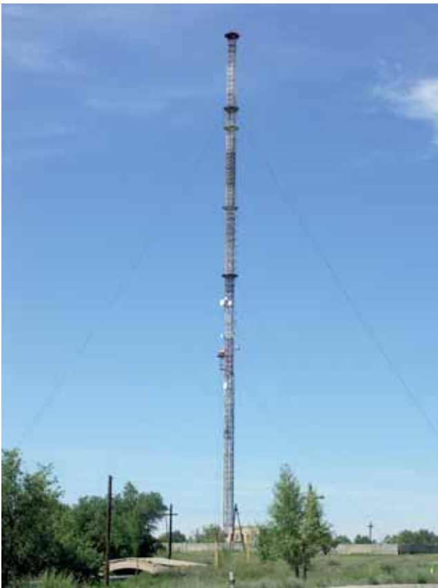
▲ Рис. 1. Мачта РТПС с тремя ярусами оттяжек ▲ Fig. 1. The RTRS mast with three levels of guy wires
