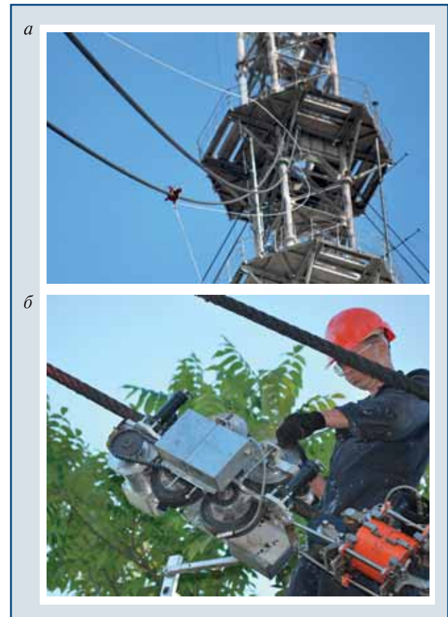
▲ Рис. 3. Перемещение дефектоскопа вдоль каната оттяжки АМС
