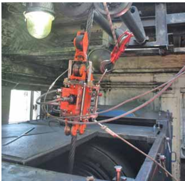
▲ Рис. 7. Автоматизированный дефектоскоп ИНТРОС-АВТО при проведении испытаний
