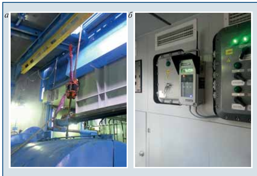
▲ Рис. 3. Дефектоскоп ИНТРОС-АВТО для мониторинга ТС талевого каната
