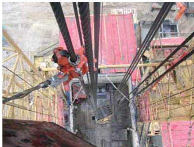
▲ Рис. 1. Обследование талевого каната БУ дефектоскопом ИНТРОС
