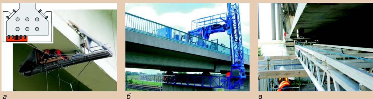
Рис. 8. Варианты осуществления перемещений дефектоскопа вдоль поверхности сканирования
